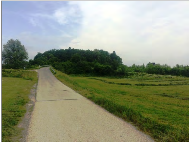
Abb. 12: Blick von Süden nach Norden auf die mit Baum- und Strauchgruppen bewachsenen Böschungen der Überführung über die Staatsstraße 2362
