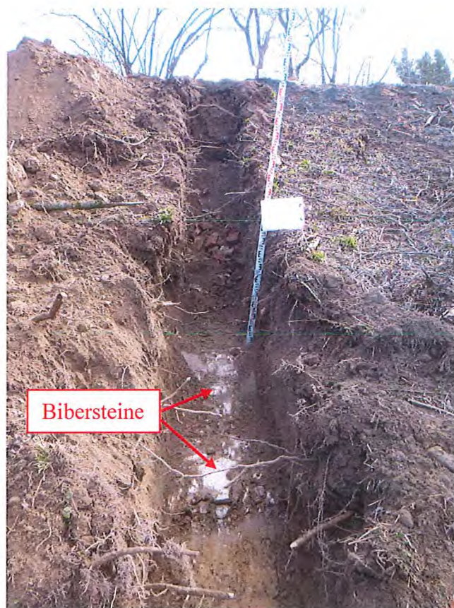
Abb.25: Baggerschurf SCH 8 im Deich
