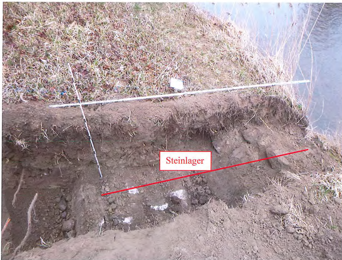
Abb.9: Baggerschurf SCH 3 im Deichvorland
