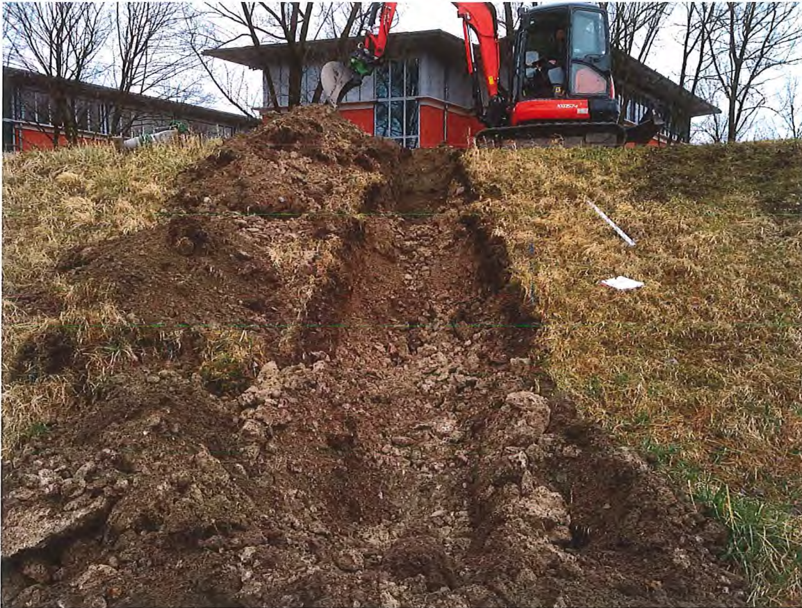
Abb.14: Baggerschurf SCH 5 im Deich
