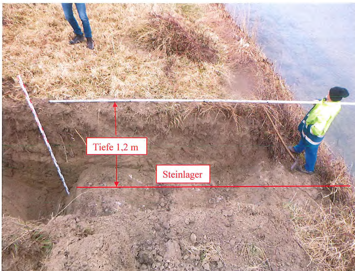
Abb.1: Baggerschurf SCH 1 im Deichvorland
