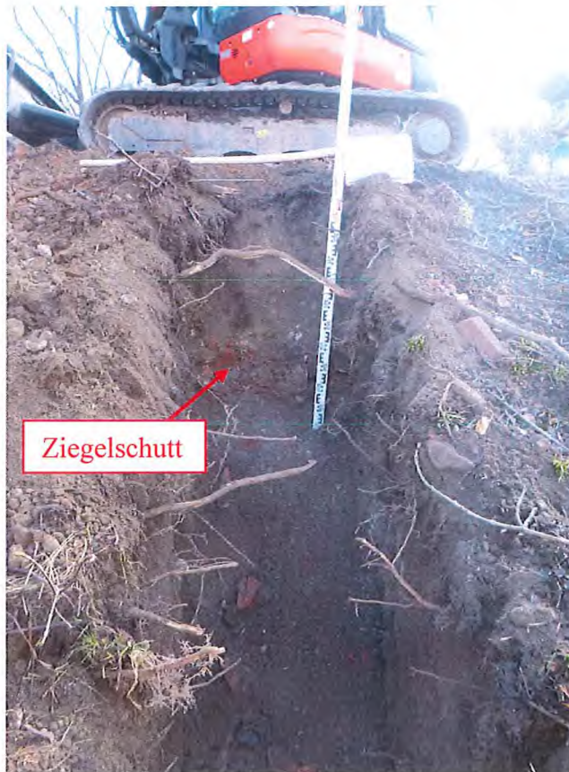
Abb.26: Baggerschurf SCH 8 im Deich oben
