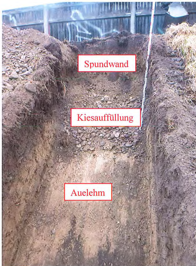
Abb.3: Baggerschürf SCH 1 im Deich
