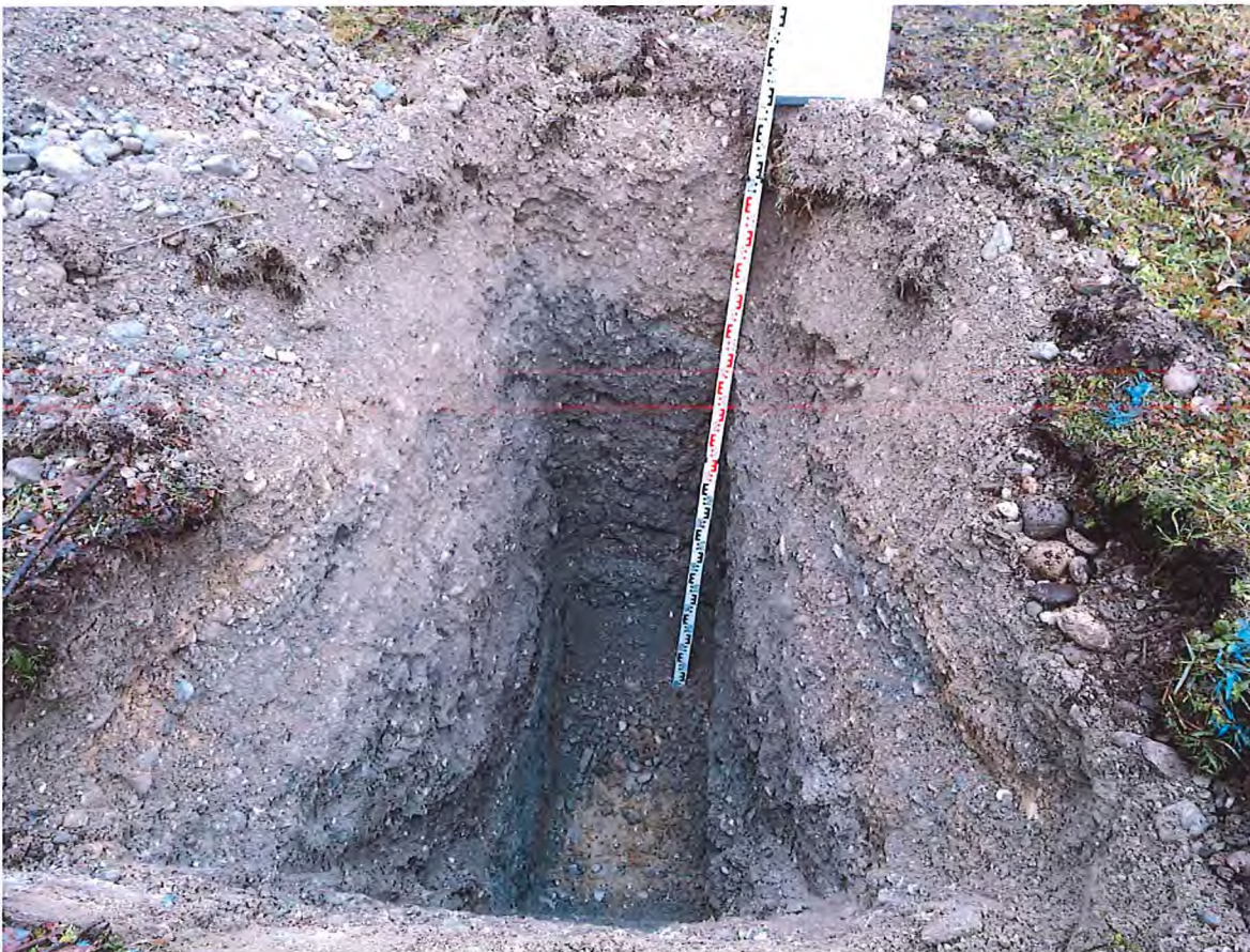
Abb.13: Baggerschurf SCH 4 (Deich ohne Innendichtung)
