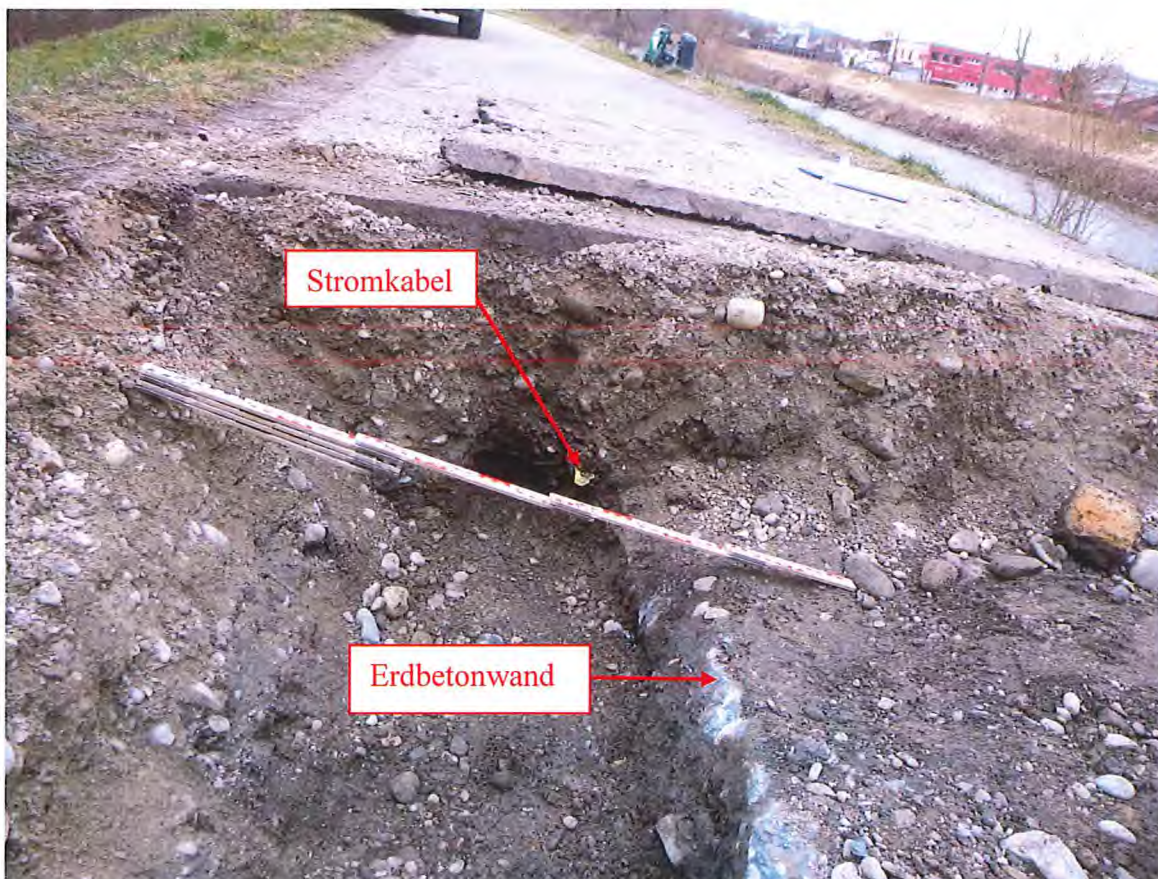
Abb.21: Baggerschurf SCH 6 im Geh- u. Radweg mit freigelegter Erdbetonwand
