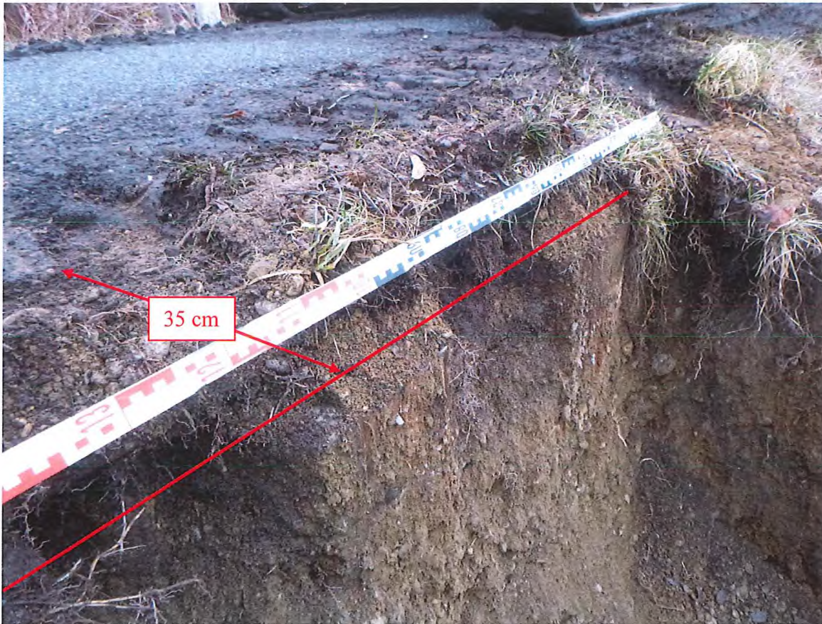
Abb.8: Spundwand im Baggerschurf SCH 2 (Spundwandachse 35 cm von Asphaltkante)
