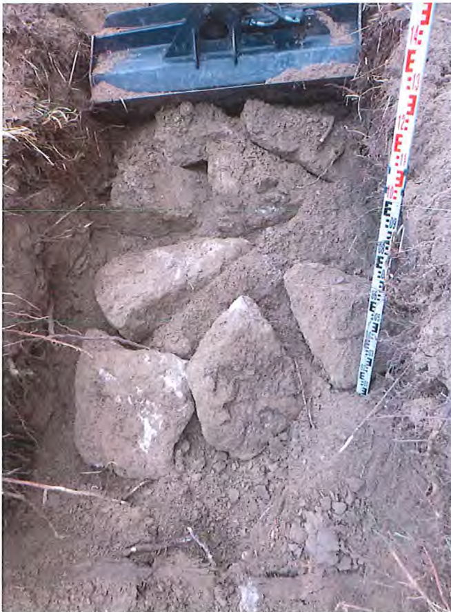
Abb.11: aufgebrochenes Steinlager in Schurf SCH3 Abb.12: Baggerschurf SCH 3 im Deich
