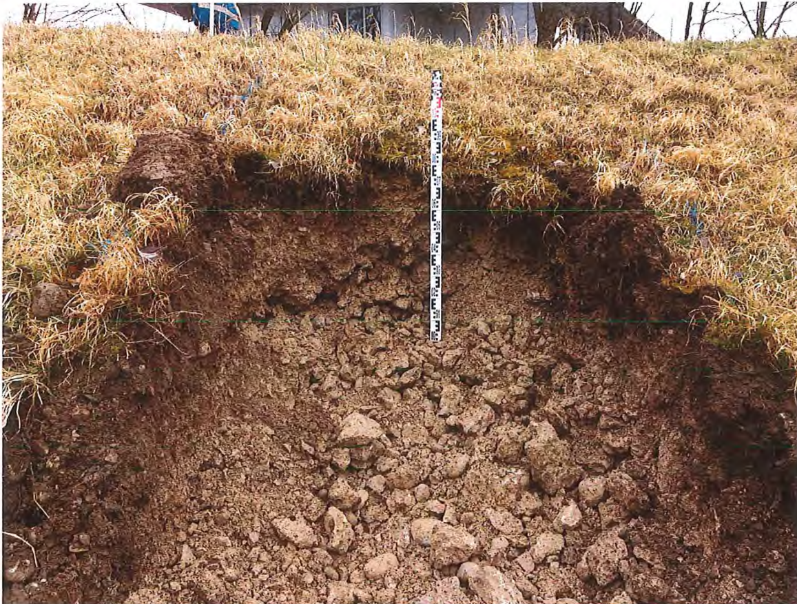
Abb.16: Baggerschurf SCH 5 im Deich mit Bibersteinauffüllung
