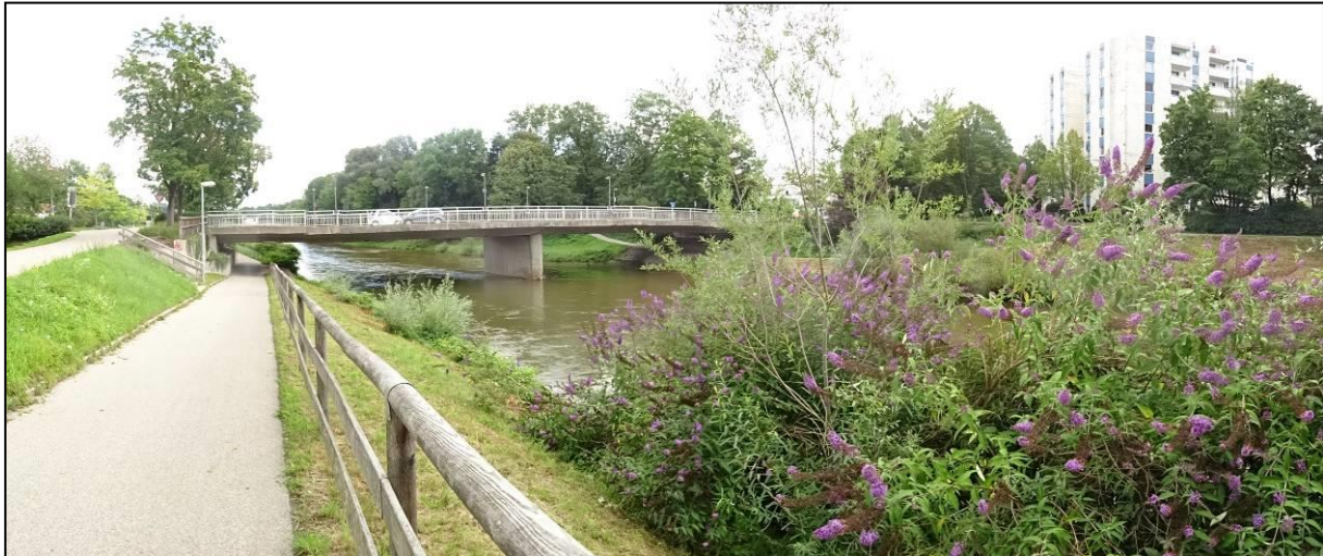
Abbildung 6 linkes Ufer der Mangfall im Oberwasser der Rathausstraßenbrücke
