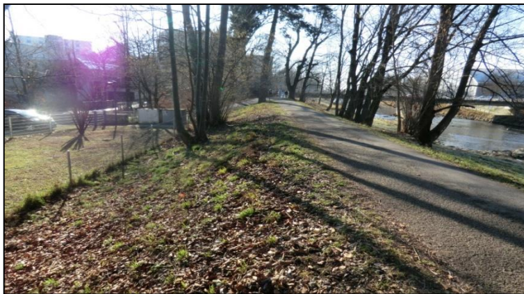
Abbildung 4-13: Hochwasserschutzdeich des Abschnitt 3.2 entlang des Kinderhorts Jonathan
