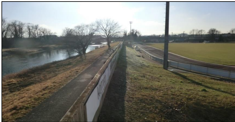
Abbildung 4-7: Hochwasserschutzdeich des Abschnitts 2.1 im Bereich des Stadions TSV 1860 Rosenheim
