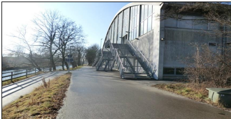
Abbildung 4-10: Abschnitt 2.4 im Bereich des Eisstadions
