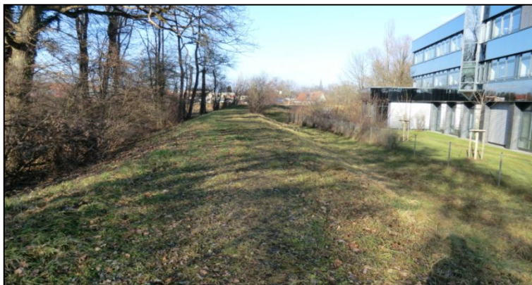
Abbildung 4-4: Abschnitt 1.1 mit dem vom Ufer abgerückten Hochwasserschutzdeich am Rand des Auwalds
