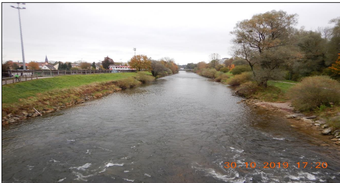
Abbildung 4-15: Projektgebiet bei „Normalwasserverhältnissen“
