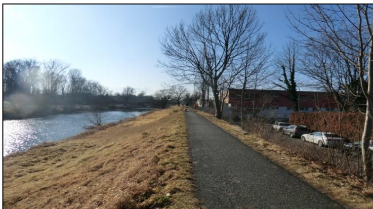
Abbildung 4-8: Hochwasserschutzdeich im Abschnitt 2.2 im Bereich der David-Eisenmann-Straße
