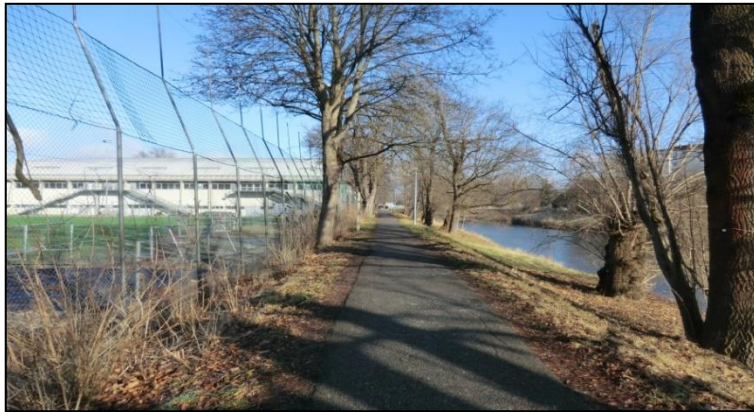
Abbildung 4-9: Hochwasserschutzdeich im Abschnitt 2.3 entlang des Trainingsplatzes des TSV 1860 Rosenheim
