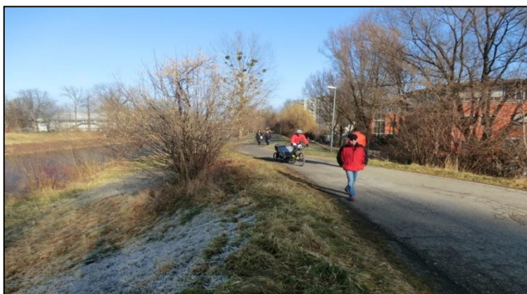
Abbildung 4-5: Hochwasserschutzdeich im Abschnitt 1.2
