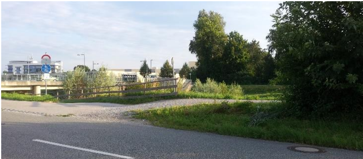
Abbildung 6: Ansicht erforderlicher Lückenschluss, Blickrichtung Nordwest
