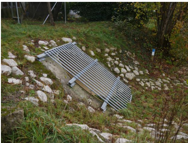
Foto 5: Einlaufbauwerk der Rohrleitung am Augrab
